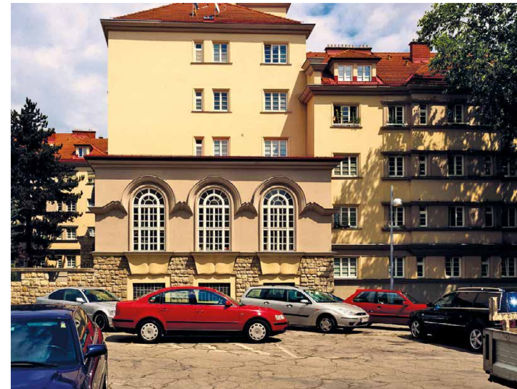
Der Sandeleitenhof ist die größte kommunale Wohnhausanlage in Wien mit mehr als 4.000 Wohnungen. Seit zwei Jahren ist auch die Kulturszene Soho vor Ort.
